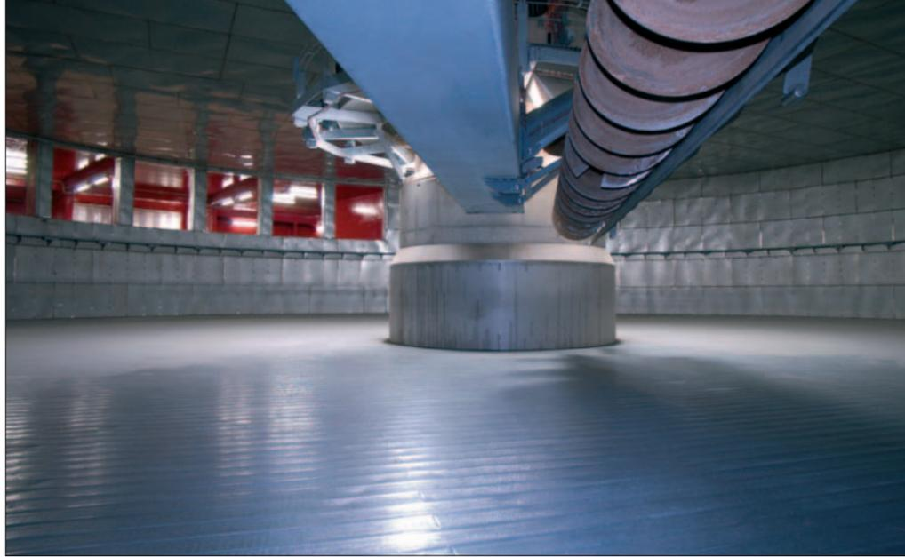
Glasrohrwärmetauscher zur Erwärmung von 1 Mio m<sup>3</sup> einströmender Frischluft.
